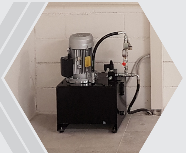
DIMENSIONI QUADRO ELETTRICO ALTEZZA 85 CM LARGHEZZA 75 CM PROFONDITÀ 35 CM
