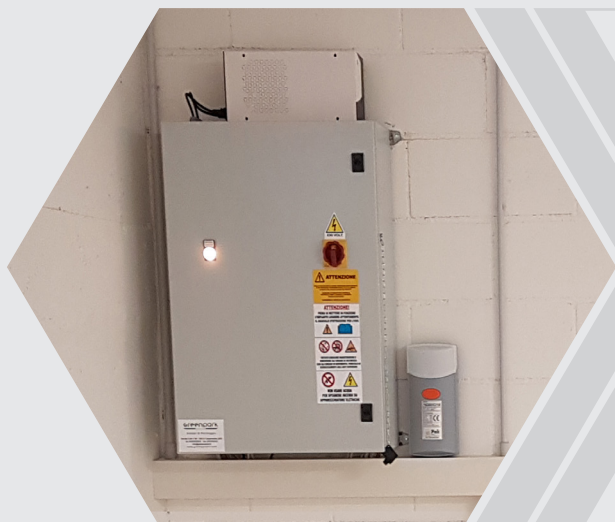
DIMENSIONI CENTRALINA IDRAULICA ALTEZZA 85 CM LARGHEZZA 60 CM PROFONDITÀ 40 CM
