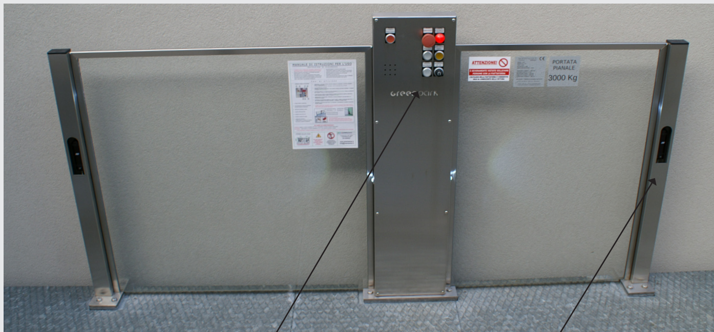
PULSANTIERA A BORDO PIATTAFORMA COMANDI A UOMO PRESENTE
