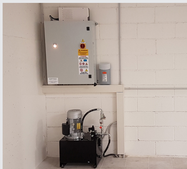
QUADRO MACCHINA E CENTRALE IDRAULICA
