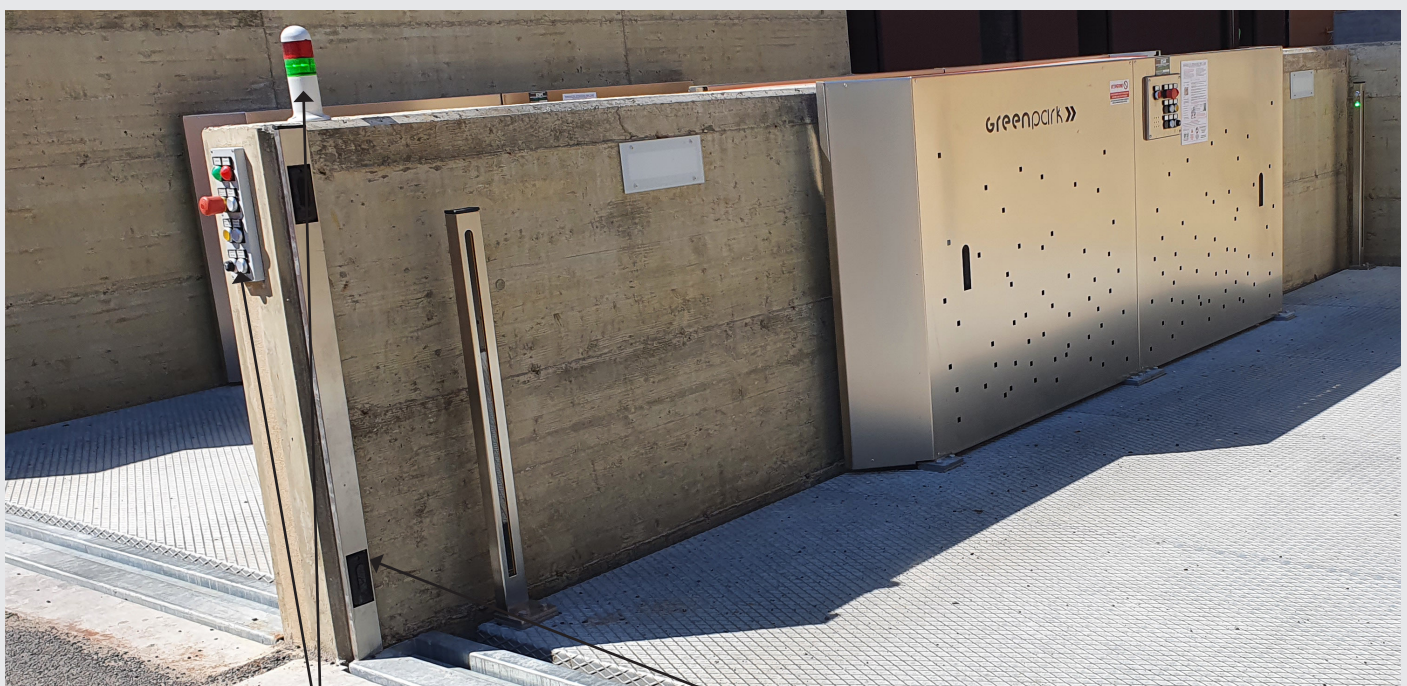
PULSANTIERA DI COMANDO COMPLETA DI SEGNALEZIONE LUMINOSA PER INDICARE LO STATO DEL MONTAUTO
