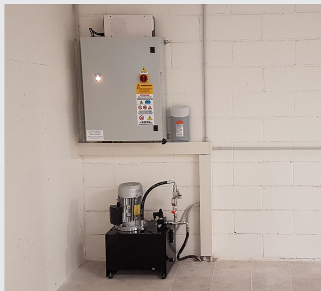
QUADRO MACCHINA E CENTRALE IDRAULICA
