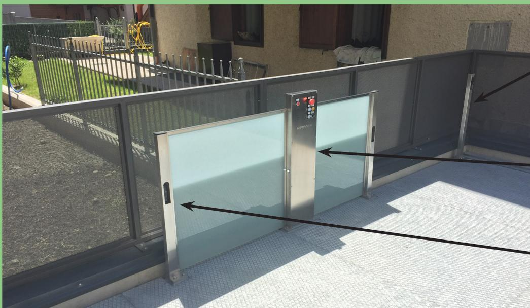
BARRIERE DI FOTOCELLULE COMPLETE DI LUCI A LED DI SEGNALE PER INDICARE IL CORRETTO POSIZIONAMENTO DELLA VETTURA
